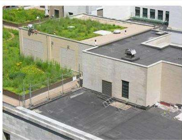
Izquierda: Edificación con Cubierta verde. Derecha: Edificación convencional.
